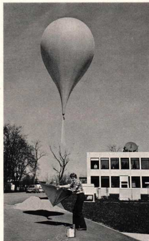
Afb. 9. De ballon wordt in een speciaal gebouw met gas gevuld en startklaar gemaakt. De radiosonde wordt op deze plaats gelanceerd.
